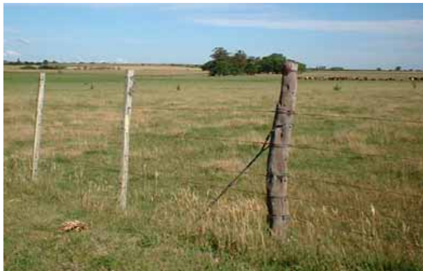
Poste central con rienda simple instalado en un alambrado de seis hilos, en línea recta. El largo total de la línea es de aproximadamente 800 metros.
