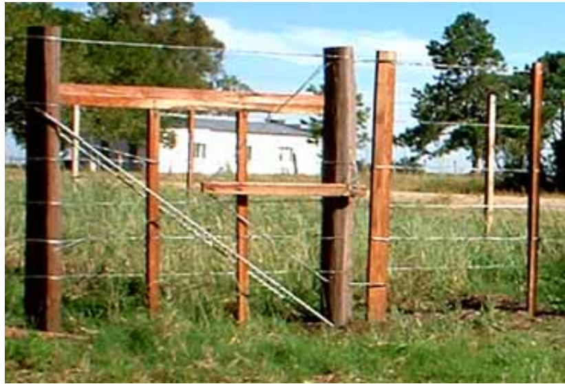
Arranque para alambrado de 7 hilos, actuando como cimbra para una portera de alambre y piques.
