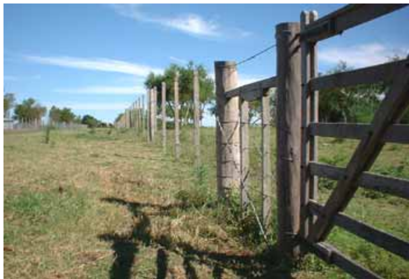
Vista en detalle de arranque a 180° para alambrado de siete hilos, línea y portera tipo ferrocarril.
