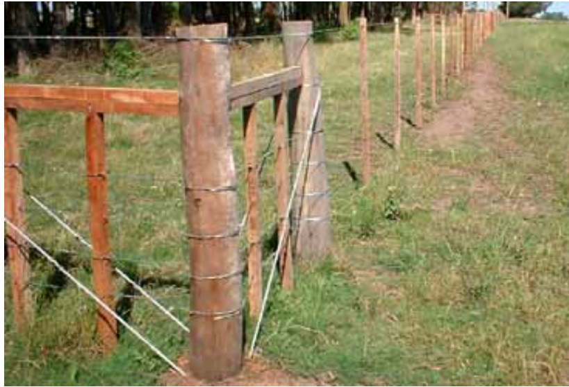
Vista en detalle de arranque a 90° para albrado de seis hilos y una de sus líneas.
