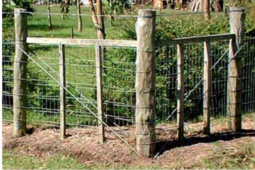
Doble arranque para alambrado de siete hilos en ángulo de 90° saliente.
