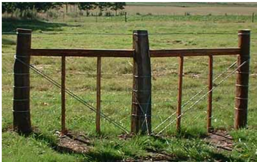
Vista en detalle de arranque intermedio sobre en ángulo de 150° para línea de seis hilos, con rienda externa en el poste central.
