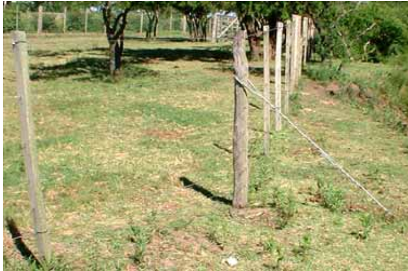
Poste intermedio con rienda externa. Para fijarlo al suelo en una quiebre entrante de 150^\circ de la línea.
